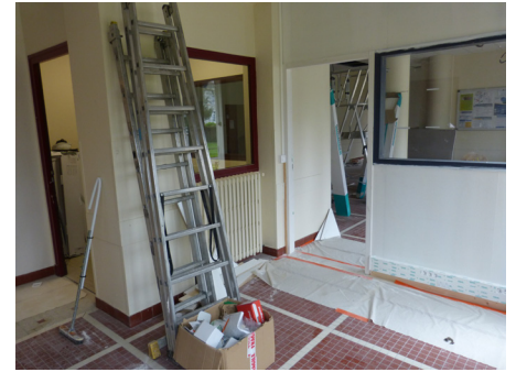
Travaux au bâtiment Ossau
