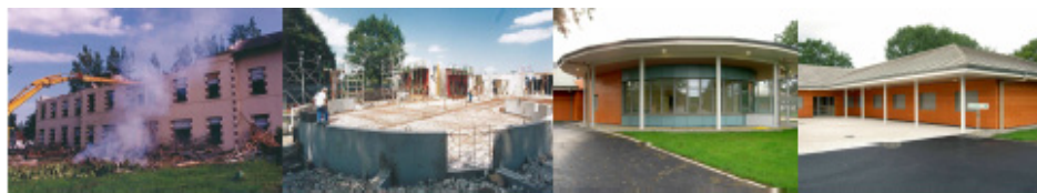
2004 : Démolition des anciens bâtiments et construction des nouvelles unités fermées.
